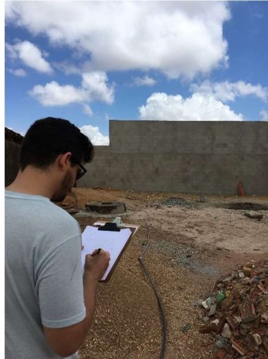
Figura 3 – Visita aos canteiros de obra
