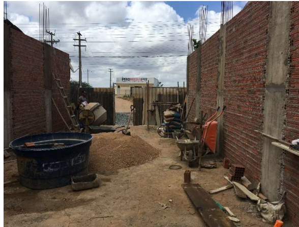
Figura 4 – Readequação do canteiro de obra
