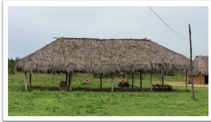
**Figura 12** – Barracão com estrutura em estacas de madeira e coberto com palhas de buriti
