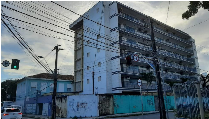
Figura 6. Edifício de seis andares do Colégio Cearense Sagrado Coração que era chamado pelos alunos de prédio novo.
