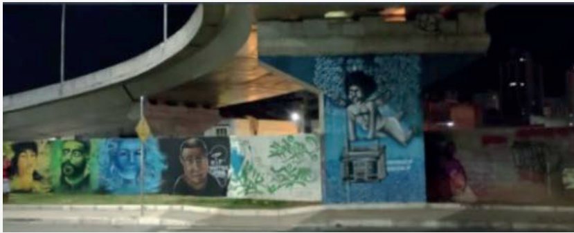
Foto: Fachada Inferior e pilastra do viaduto Hélio Fadel
