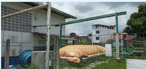
O Biodigestor da BERSO funciona a partir da decomposição de resíduos sólidos orgânicos. Onde os microrganismos se alimentam da matéria orgânica, e através de alguns processos químicos, ocorre a geração do Biogás e de fertilizantes naturais. Tal equipamento serve como uma alternativa de tratamento sustentável, reaproveitando esses resíduos e se tornando responsável por devolvê-los à natureza com um impacto reduzido. Cumprindo com dois objetivos de desenvolvimento sustentável:
